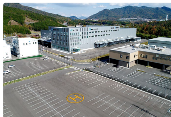
ヘリポートの設置
